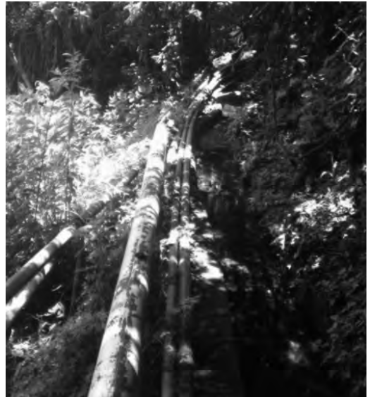
Ilustración 5. Canal de Riego. Fuente: Elaboración propia.
