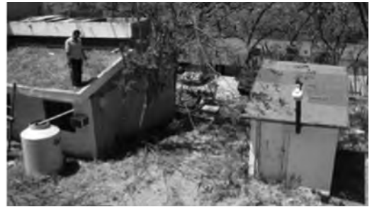
Figura 8. Vista de los techos comparados, techo de concreto reforzado y techo verde.
