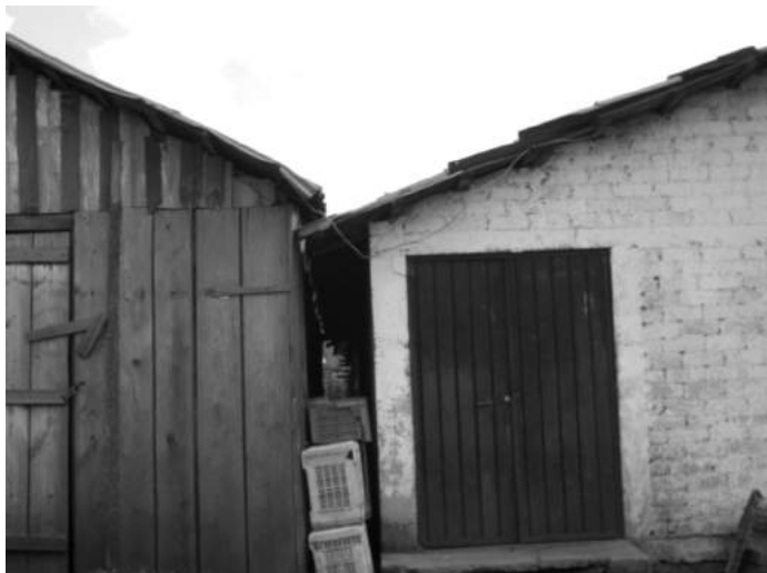
Fotografía 10. Cambio del tipo materiales en la construcción de la vivienda Fuente: Ramírez, 2010
