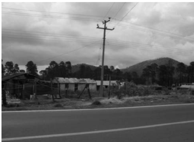
Fotografía 14. Redes de Servicios, energía eléctrica e infraestructura Fuente: Ramírez, 2010
