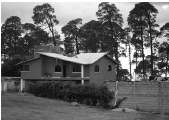
Fotografía 11. Cambio del tipo materiales en la construcción de la vivienda Fuente: Ramírez, 2010
