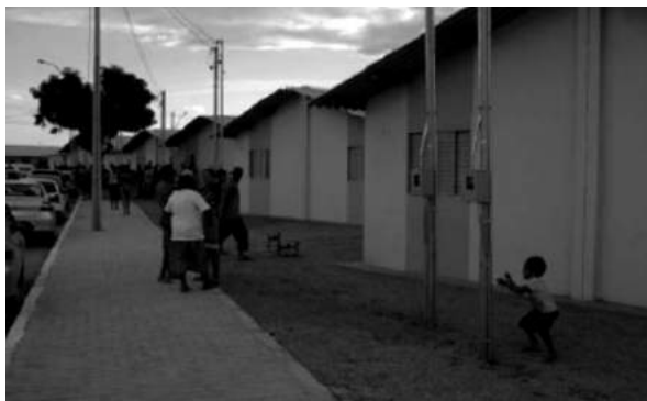
Imagen 5. Aspecto general de los caminos y las casas construidas Fuente: Programa Brasília Sustentable, GDF/Word Bank, 2008
