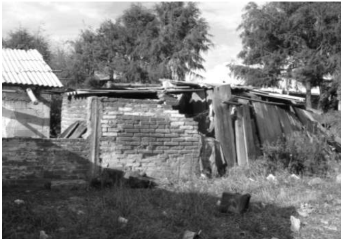
Fotografía 9. Baños en el exterior de la vivienda Fuente: Ramírez, 2010
