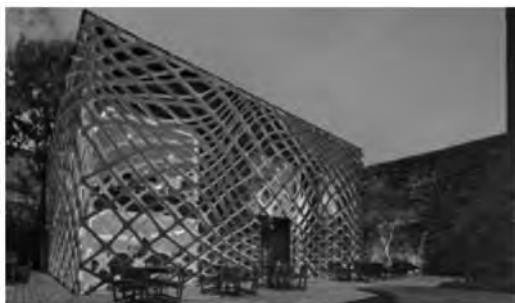
Figura 3. Restaurante japonés Tori Tori (Diseñado por Michael Michel Rojkind Esware Studio). Logrando crear una fachada con características orgánicas. Así como la implementación de las tecnologías constructivas más avanzadas para poder desarrollar la piel principal. Fuente: http://www.eluniversaledomex.mx/ , consultado el 22 de julio de 2014.
