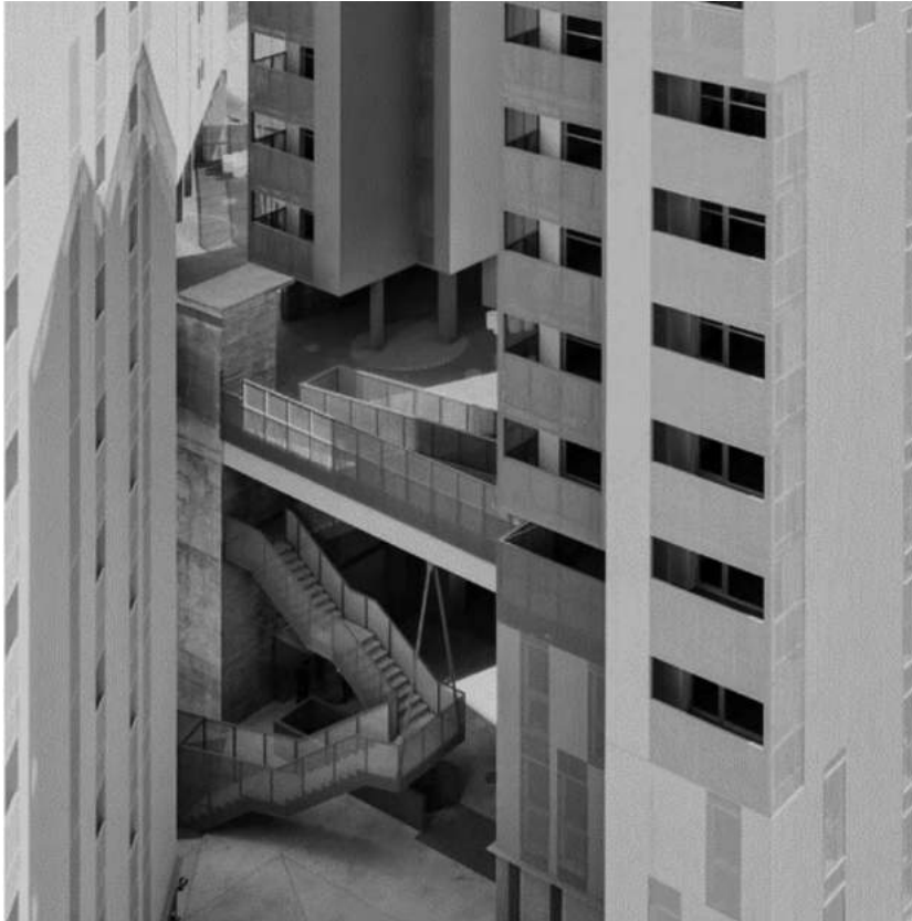
Gráfico 5. Edificio Uso Mixto. 118 viviendas de interés social, oficinas, locales comerciales y estacionamiento. Madrid, España. Proyecto: Amann, Canovas y Maruri. Fotografía: David Frutos, 2012.
