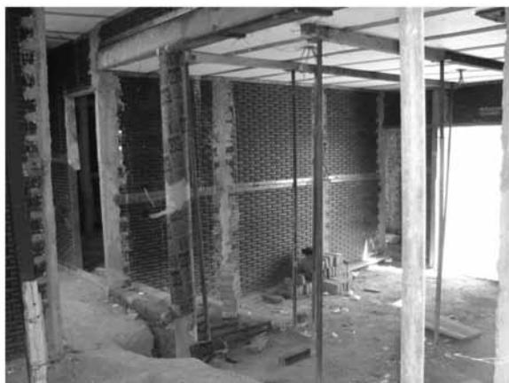
Imagen 7. Foto del sistema de techo (Vigueta y Bovedilla).
