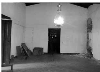
Foto 7. Vista interior del ala principal de la vivienda a intervenir. Fuente: propia, 2012.
