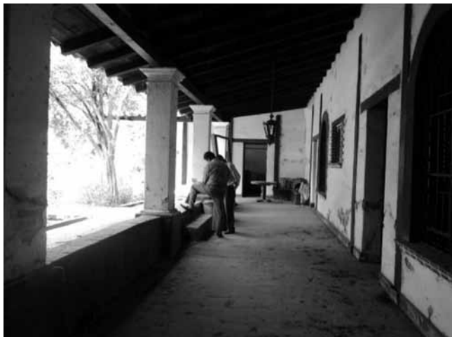
Foto 10. Vista interior del corredor principal del Museo José Juárez antes de su intervención. Fuente propia, 2012.
