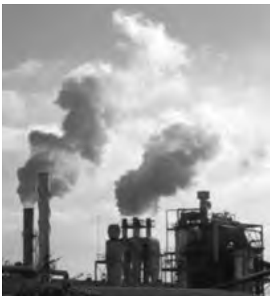
Fotografía 1. Refinería en Tuxpan, Veracruz. Fuente: Cambio Climático http://www.uv.mx/universo/371/campus/campus_02.htm
