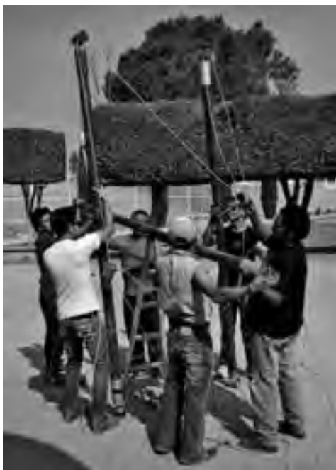
Figura 5d. Maqueta a escala, hecha de madera, anillos e hilo elástico Fuente: Imagen proporcionada por el autor (2012)
