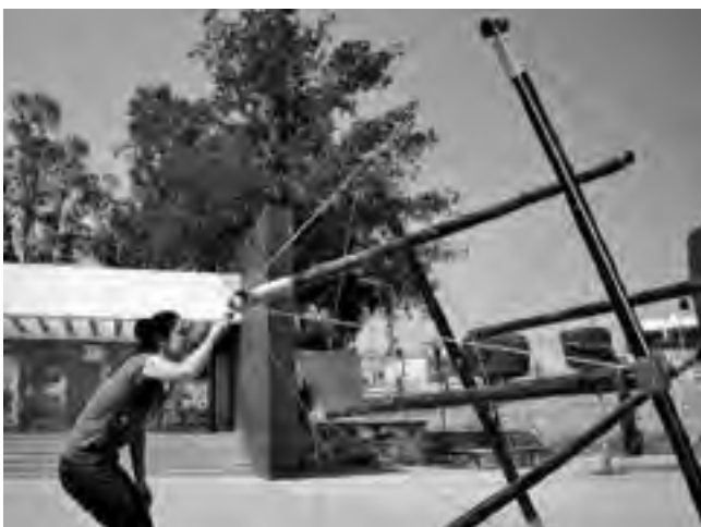
Fig. 7f. Con la estructura tensegrítica ensamblada y montada se puede apreciar una estabilidad que es muy gratificante y que despierta diferentes sensaciones espaciales al ver barras de bambú flotando por medio de cables unidos entre sí de manera muy ligera y estable Fuente: Imagen proporcionada por el autor (2012)
