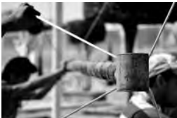
Fig.7d. Soporte de las barras de bambú guadua angustifolia Kunth para poder abrir la estructura de forma convexa Fuente: Imagen proporcionada por el autor (2012)
