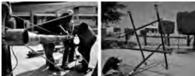
Fig.7b. Detallado de los???, con lo liviano de la estructura se rotaba para detallar los nodos ya tensados Fig. 7c. Supervisión de la correcta posición de las barras de Bambú Guadua angustifolia Kunth para lograr su estabilidad, y con las barras trabajando al ángulo previsto Fuente: Imagen proporcionada por el autor (2012)
