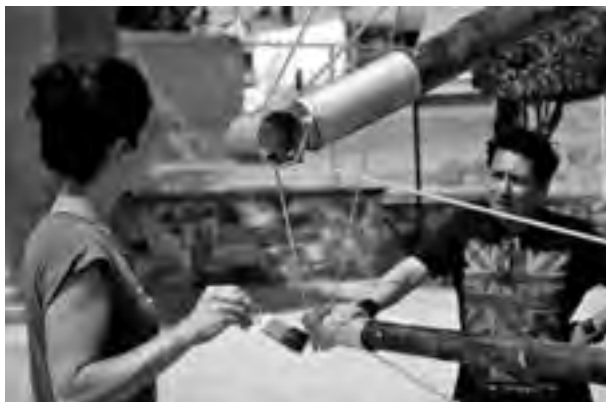
Fig.7a. Fijación del Bambú Guadua angustifolia Kunth , con ayuda de 5 personas para mantener estabilidad y facilitar las maniobras de montaje Fuente: Imagen proporcionada por el autor (2012)
