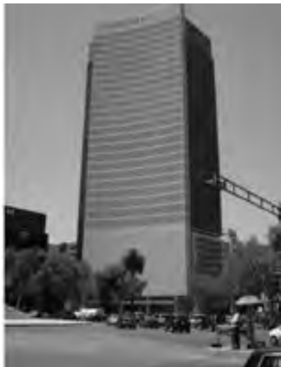
Fotografía 7. Torre HSBC en México, DF.
