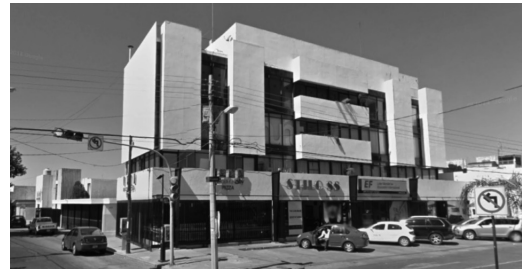
Imagen 5. Vista actual del edificio, Av. Américas #602 esq. Av. Roma. Fuente: fotografía de Aguilar Rangel Julio César.
