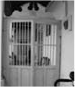
Imagen 4. Fotografía. Puerta interior. Fuente: González (2014).
