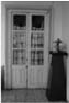
Imagen 11. Fotografía. Puerta interior. Fuente: González (2014).
