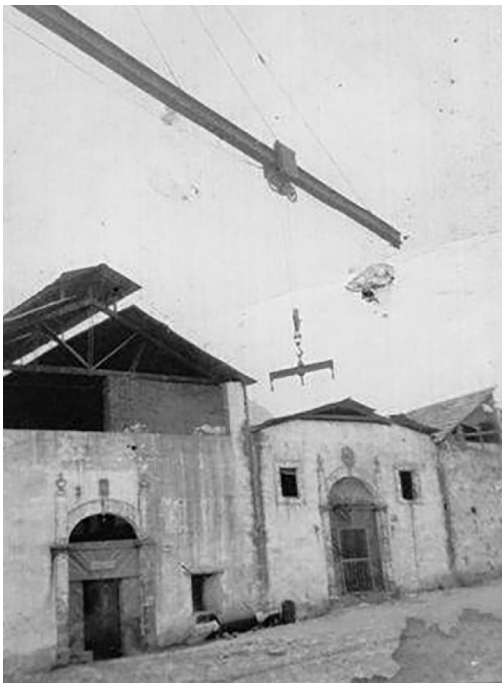
FIGURA 6. PROCESO DE SUSTITUCIÓN DE ELEMENTOS ARQUITECTÓNICOS, INGENIO PEDERNALES, CA. 1958. FUENTE: FOTOGRAFÍA TOMADA DE https://www.facebook.com/10004777336223/posts/368320579985882 .
