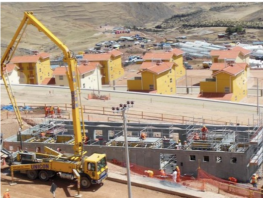
FIGURA 6. CONSTRUCCIÓN DE VIVIENDAS.
