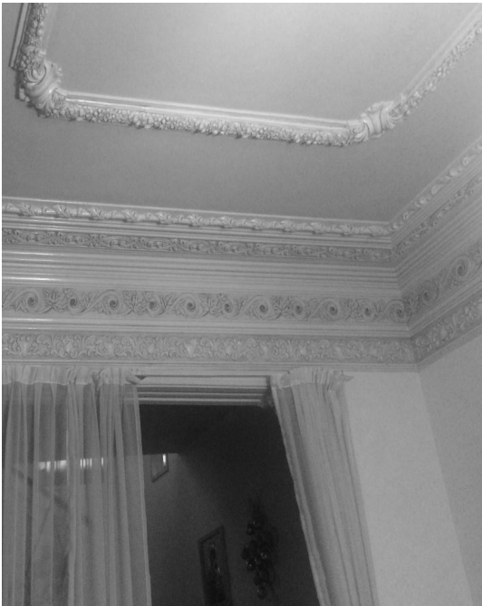
FIGURA 8. DETALLES DE TIROL EN VIVIENDA BURGUESA DE LA CALLE 27 DE SEPTIEMBRE, LEÓN, MÉXICO. FUENTE: FOTOGRAFÍA DE LOS AUTORES.
