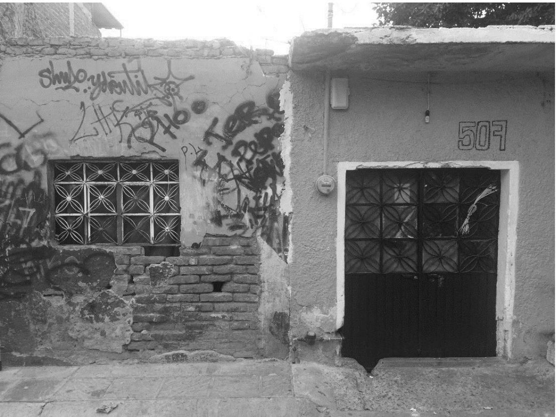
FIGURA 6. VIVIENDAS EN LA CALLE NORIEGA, LEÓN, MÉXICO.
