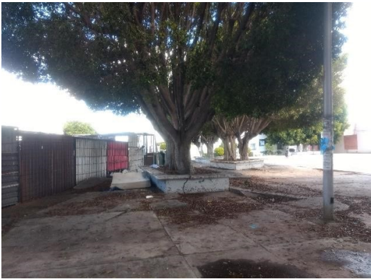
FIGURA 4. ESTADO ACTUAL DE ALGUNAS ÁREAS COMUNES. NOTA: A FALTA DE MANTENIMIENTO EN LOS ÁRBOLES HA ORIGINADO QUE EN EL PROCESO DE CRECIMIENTO LAS RAÍCES FRACTUREN/LEVANTEN EL PAVIMENTO. FUENTE: FOTOGRAFÍA DE LOS AUTORES.
