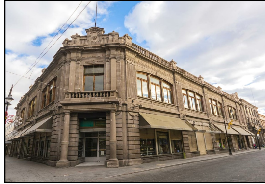
FIGURA 5. EDIFICIO COMERCIAL “LA EXPOSICIÓN” (2020).
