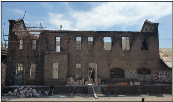
FIGURA 13. TRABAJOS DE RESTAURACIÓN EN MUROS Y VANOS DE CANTERÍA DE LA ANTIGUA ESTACIÓN DE CARGA. FUENTE: FOTOGRAFÍA DE LOS AUTORES (2021).
