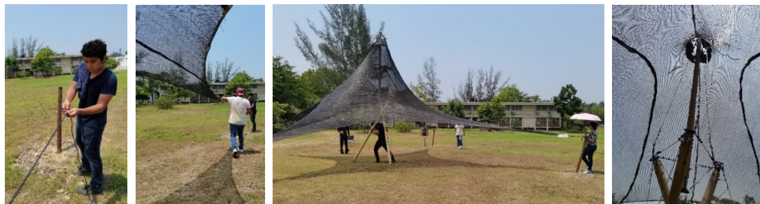
FIGURA 49-52. ARMADO DE LA CUBIERTA CON EL MÓDULO PRISMÁTICO TRIANGULAR. FUENTE: MORALES, 2019A.
