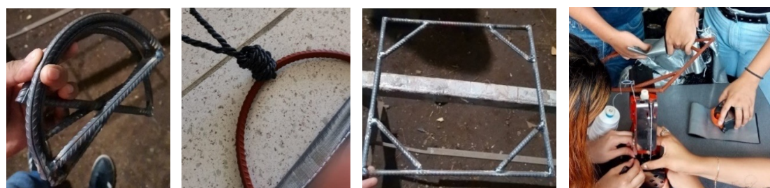
FIGURA 45-48. MANUFACTURA DE LOS DETALLES DE UNIÓN DE LA CUBIERTA.
