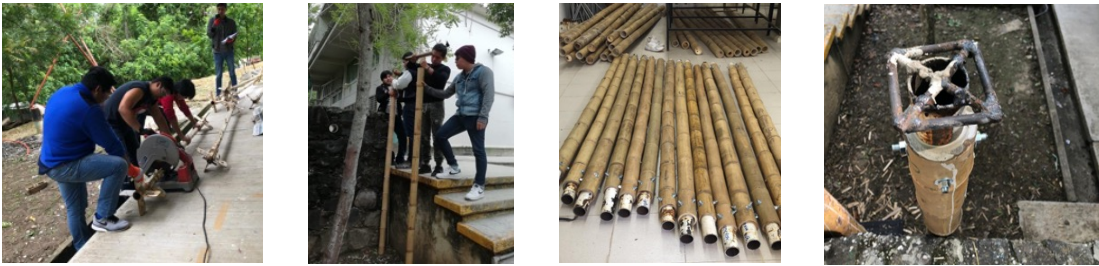
FIGURA 24-27. CONSTRUCCIÓN DE LAS BARRAS DE BAMBÚ.
