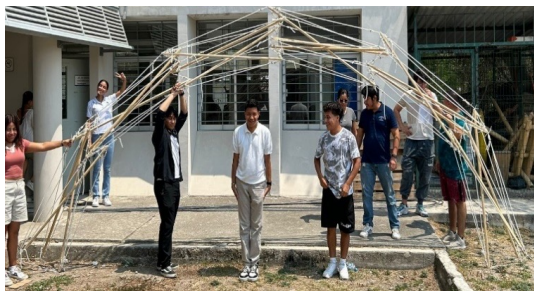
FIGURA 59, 60. CUBIERTA PRISMÁTICA MODULADA TERMINADA.
