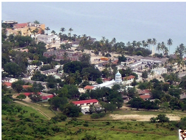
FIGURA 1. CAMPAMENTO BALLETO DE LA EXTINTA COLONIA PENAL FEDERAL ISLAS MARIÁS (2003).
