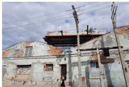
Figura 2. Edificación industrial usada como vivienda.
