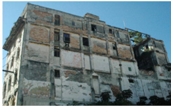
Figura 1. Edificio de viviendas.
