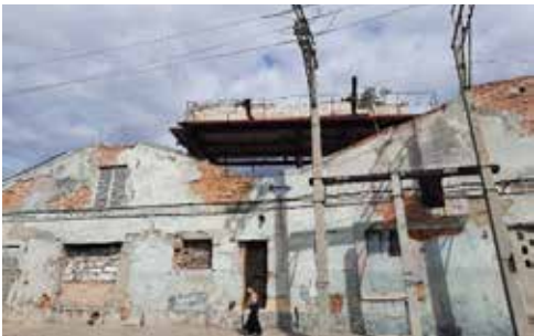
FIGURA 2. EDIFICACIÓN INDUSTRIAL UTILIZADA COMO VIVIENDA. FUENTE: LAS FAMILIAS Y SU HÁBITAT. ÁREA DE ESTUDIO ATARES. CURSO 2021-2022.
