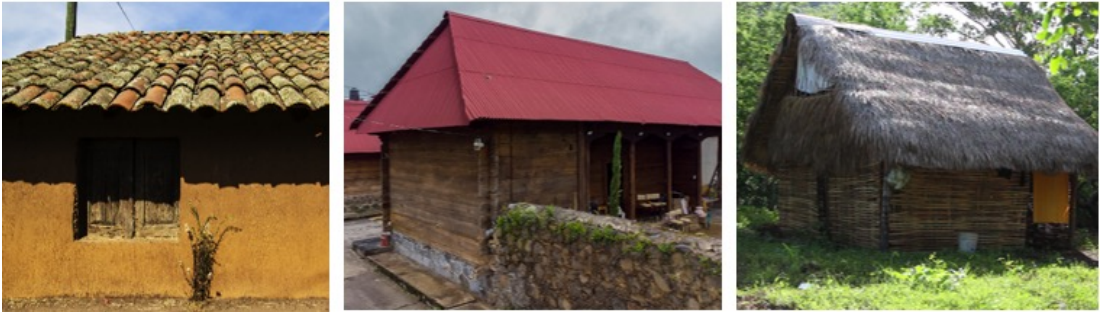
FIGURA 4. EJEMPLOS DE VIVIENDA VERNÁCULA DE MICHOACÁN: VIVIENDA DE ADOBE EN SAN NICOLÁS DE OBISPO, TROJE PURÉPECHA EN CHARAPAN, CONSTRUCCIÓN DE BAJAREQUE EN SANTA CRUZ DE MORELOS.
