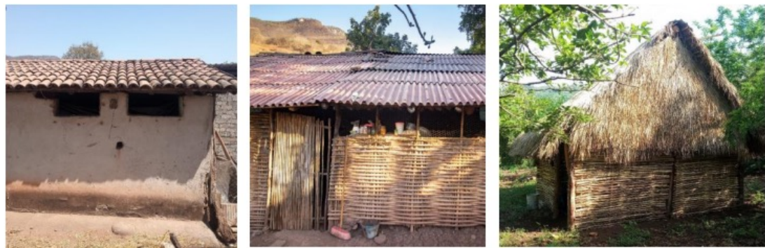
FIGURA 6. SOLUCIONES DE CUBIERTA EN VIVIENDAS VERNÁCULAS DE SANTA CRUZ DE MORELOS. FUENTE: FOTOGRAFÍAS DE ADRIÁ SÁNCHEZ.
