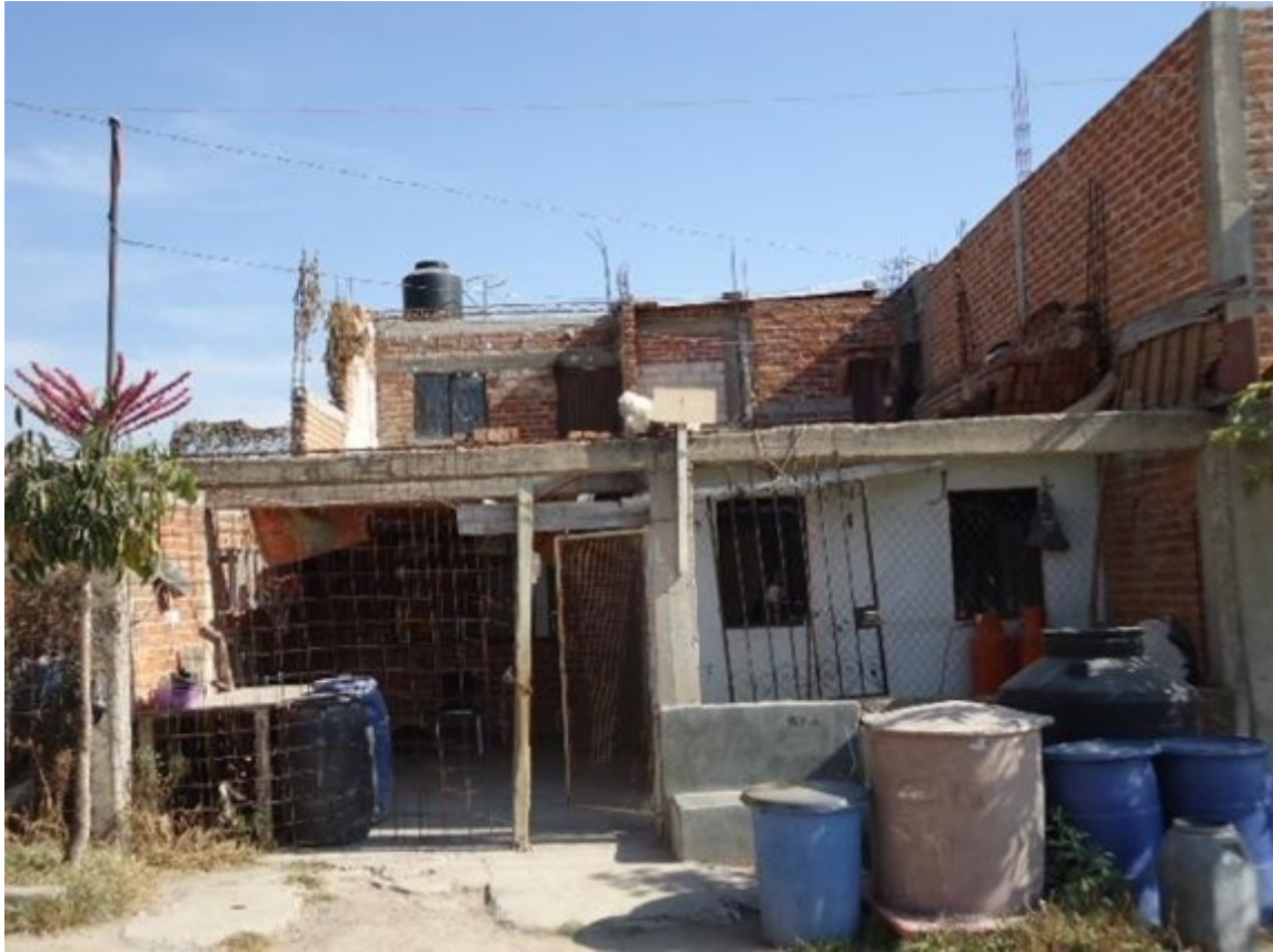
Figura 11. Vivienda informal, tipología: en proceso de construcción, ubicada en colonia “cañada del Real”.
