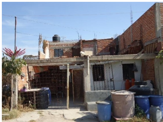
FIGURA 11. VIVIENDA INFORMAL, TIPOLOGÍA: EN PROCESO DE CONSTRUCCIÓN, UBICADA EN COLONIA "CANADA DEL REAL".
