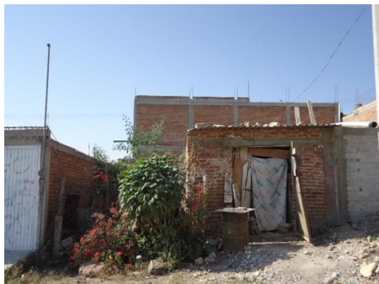
FIGURA 9. VIVIENDA INFORMAL, TIPOLOGÍA: ETAPA INICIAL, UBICADA EN LA COLONIA "SIGLO XXI".
