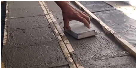
FIGURA 1. APLICACIÓN DEL ACABADO FINO EN LOS SUSTRATOS.
