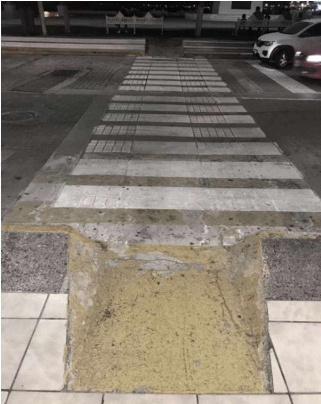
Figura 6. Cruce peatonal ubicado en Av. Morelos.
