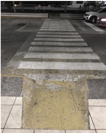
FIGURA 6: CRUCE PEATONAL UBICADO EN AV. MORELOS. FUENTE: FOTOGRAFÍA DE LOS AUTORES.
