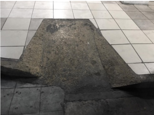
FIGURA 5: RAMPA UBICADA EN CALLE JUÁREZ. FUENTE: FOTOGRAFÍA DE LOS AUTORES.
