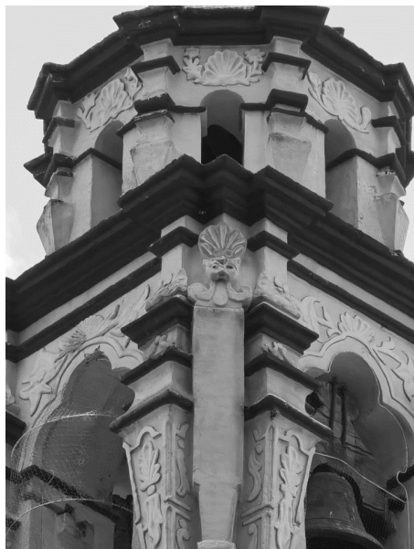
FIGURA 2. DETALLE DE LA TORRE NORTE DEL SANTUARIO DE NUESTRA SEÑORA DEL RAYO EN ZINACANTEPEC.
