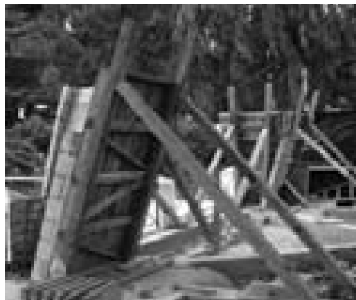
Fotografía 2. Dalas de cruz cuya función es impedir que los soportes de la cúpula se abran. Fuente: Información propia.
