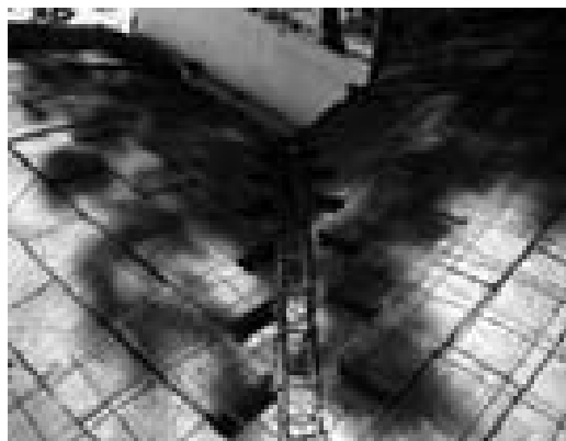
Fotografía 8. Nervaduras de refuerzo. Fuente: Información propia.
