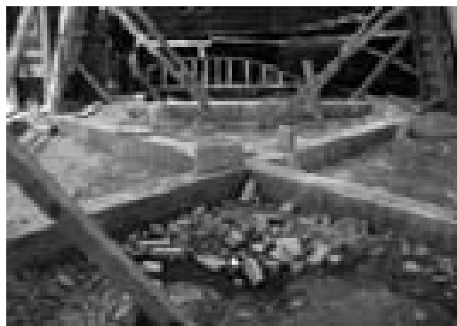
Fotografía 2. Dalas de cruz cuya función es impedir que los soportes de la cúpula se abran. Fuente: Información propia.
