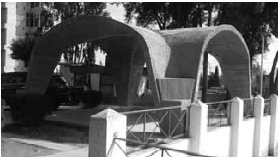
Fotografía 1. Edificación correcta de la cúpula con técnica mixta. Fuente: Información propia.
