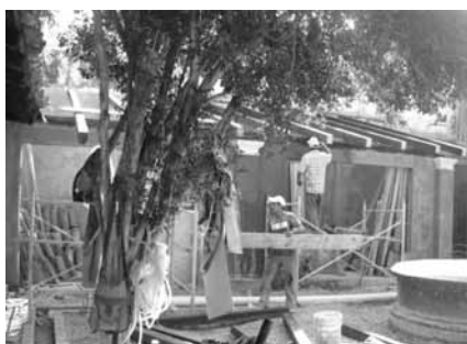
Foto 8. Sustitución de piezas dañadas en techumbre. Fuente: propia 2013.
