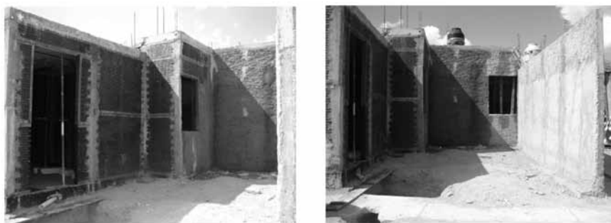
Imagen 5. Fotos del proceso constructivo. Fuente: elaboración propia, tomadas en Aguascalientes, México.
