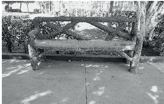
FIGURA 13. USO DEL CONCRETO ARMADO EN LAS BANCAS DE LA ALAMEDA DE SILAO. FUENTE: ELABORACIÓN PROPIA (2020).
