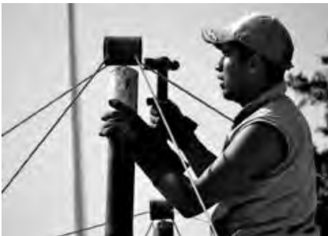
Fig. 7e. Tensado y ajuste de la estructura Fuente: Imagen proporcionada por el autor (2012)
