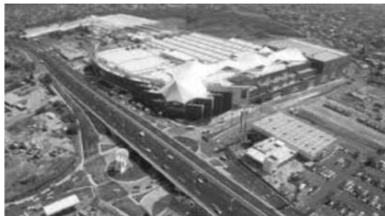
Imagen 3. Vista área de Galerías Cuernavaca .
