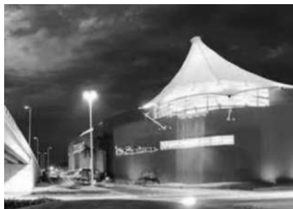
Imagen 4. Vista de perfil de Galerías Cuernavaca .
