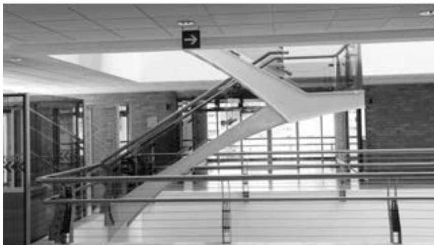
IMAGEN 2. Escaleras y Vestíbulo, Edificio PGJE, en la Ciudad de Zacatecas, Zacatecas, SECOP 2010 2
