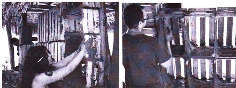
Figura 9. Construcción del 'muro huacal' Vivienda en el trópico.
