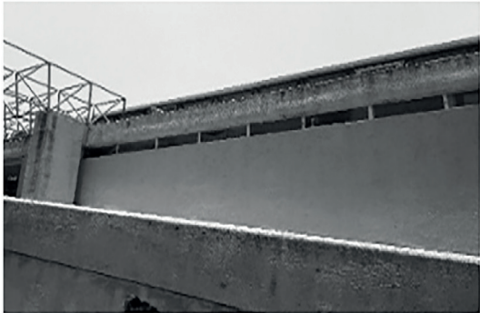
FIGURA 10. COLOR NARANJA. FUENTE: INSTALACIONES UASLP, ELABORACIÓN PROPIA.
