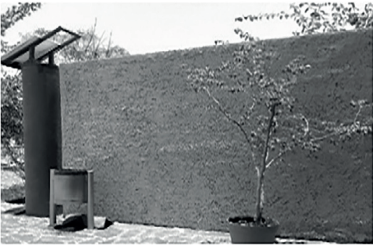
FIGURA 8. COLOR BEIGE. FUENTE: INSTALACIONES UASLP, ELABORACIÓN PROPIA.
