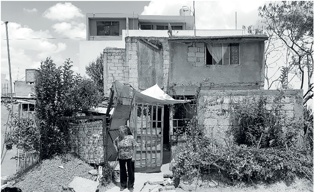
FIGURA 1. VIVIENDA PRECARIA DE AUTOCONSTRUCCIÓN EN ASENTAMIENTOS PERIURBANOS.
