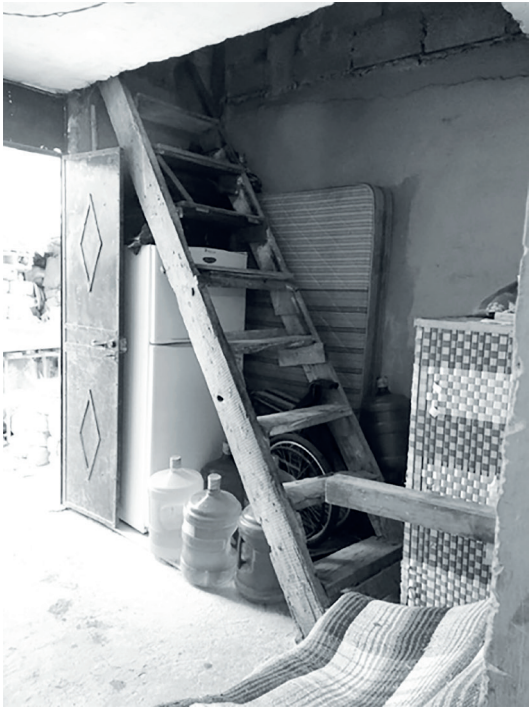
FIGURA 7. ESCALERA IMPROVISADA COMO EJEMPLO DE ELEMENTO DE RIESGO. FUENTE: DÍAZ (2019).
