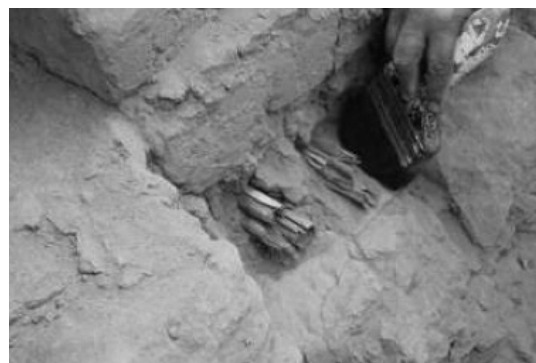
FIGURA 2. AL RECUBRIR EL BAMBÚ CON TIERRA SE GARANTIZA SU VIGENCIA SECULAR POR EL EQUILIBRIO DE SU NIVEL DE HUMEDAD. REFUERZOS ENTRE ADOBES CON MÁS DE MIL AÑOS. HUACAS DE MOCHE, PERÚ.
