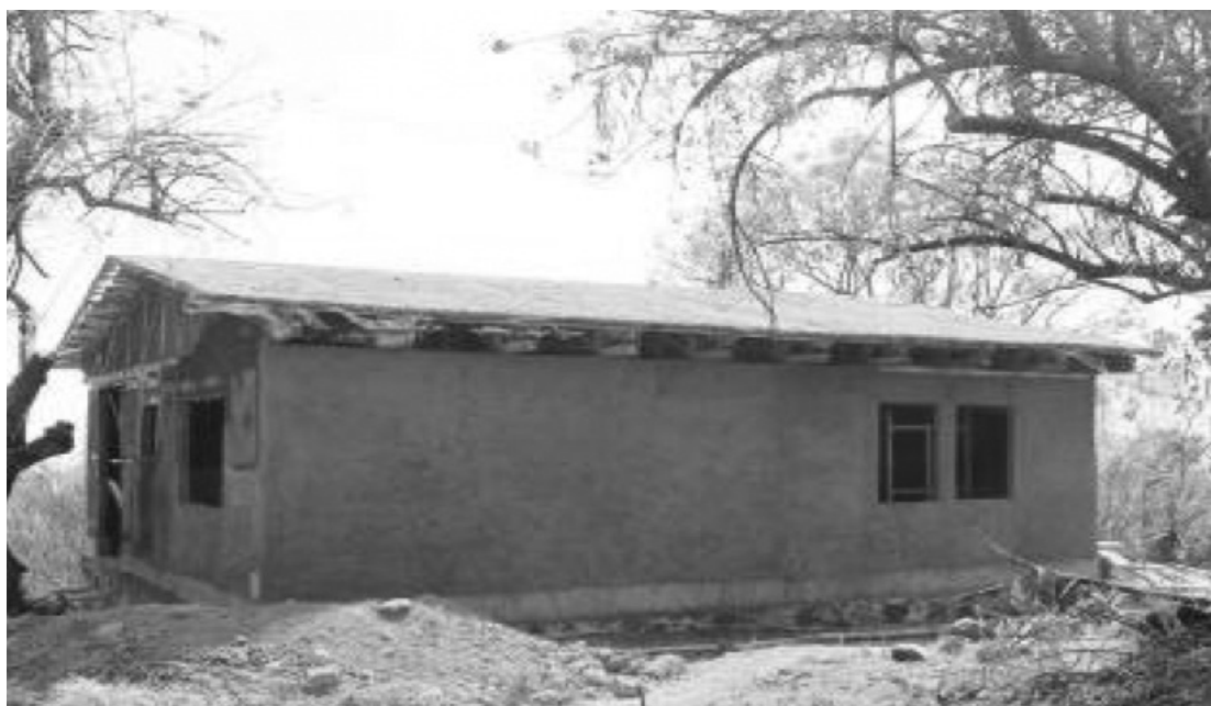
FIGURA 8. EL PROCESO CONSTRUCTIVO DESARROLLADO A PARTIR DE LA COMBINACIÓN DE POLINES DE BAMBÚ ENSAMBLADOS HA SIDO PROBADO PARA VERIFICAR SU APLICABILIDAD, COSTOS Y RENDIMIENTOS DE OBRA.
