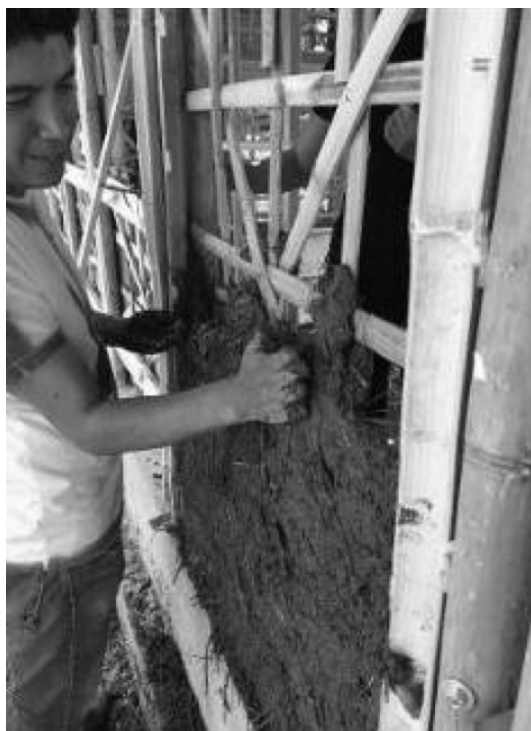
FIGURA 7. EL PROCESO DE COBERTURA DE LOS PANELES CONFORMA UNA ETAPA FUNDAMENTAL PARA CONSEGUIR UNA ARTICULACIÓN COMPLETA DEL SISTEMA.
