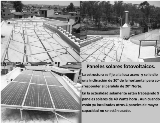
FIGURA 7. COLOCACIÓN DE PANELES SOLARES.
