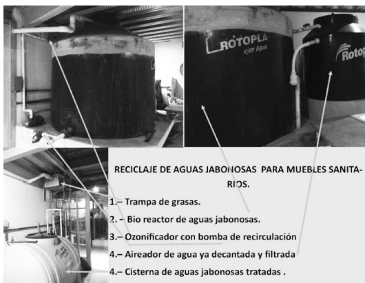
FIGURA 5. PROCESO DE RECICLAJE DE AGUAS JABONOSAS.
