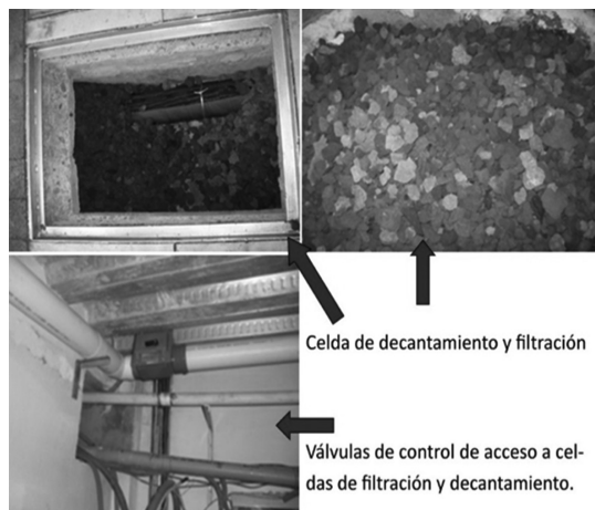
FIGURA 2. TRATAMIENTO DEL AGUA DE LLUVIA.
