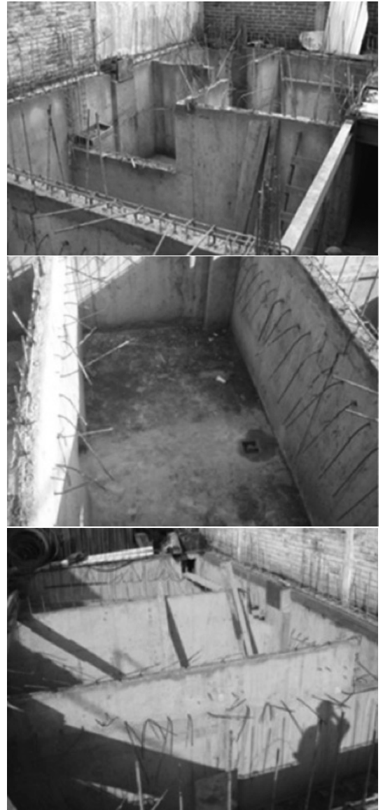
FIGURA 1. ALFJE PRINCIPAL DE 54M 3 CONSTRUIDO CON LOS MUROS DE CONCRETO ARMADO Y ESTRUCTURADO CON CELDAS.
