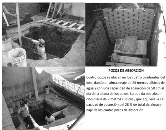
FIGURA 3. PROCESO DE CONSTRUCCIÓN DEL POZO DE ABSORCIÓN.
