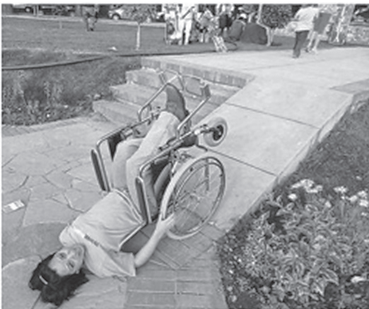
FIGURA 1. CAÍDA EN RAMPA CON PENDIENTE DE MÁS DE 12% QUE GENERA BARRERA ARQUITECTÓNICA.
