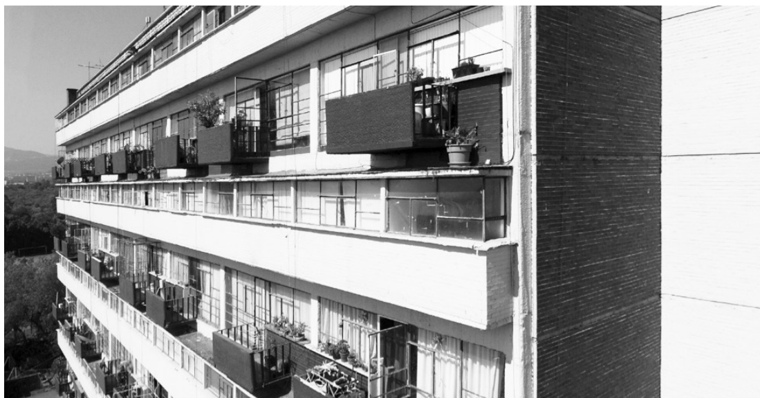
FIGURA 6. VISTA DEL MULTIFAMILIAR DE CIUDAD UNIVERSITARIA. SE OBSERVAN LOS BALCONES EN LA PLANTA BAJA DE LOS DÚPLEX Y EL CUERPO EN VOLADIZO DE LAS RECÁMARAS EN LA PLANTA ALTA DE LOS MISMOS.
