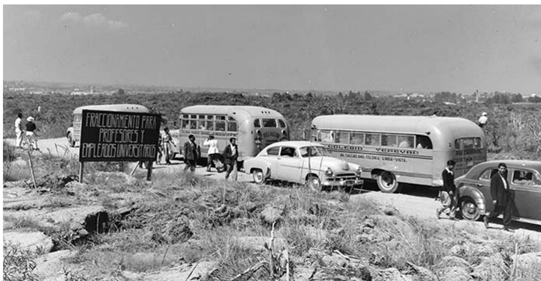
FIGURA 2. PROFESORES Y EMPLEADOS UNIVERSITARIOS EN RECORRIDO POR LAS OBRAS DE CONSTRUCCIÓN DE LA CIUDAD UNIVERSITARIA, CA. 1951. EN LA FOTOGRAFÍA SE OBSERVA UN LETRERO QUE INDICA EL EMPLAZAMIENTO DEL FRACCIONAMIENTO PARA PROFESORES Y EMPLEADOS UNIVERSITARIOS.
