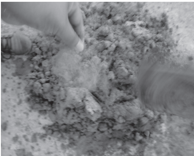
FIGURA 3 Y 4. PROCESO DE RELLENO CON LA MEZCLA DE SUELO Y DIFERENTES AGREGADOS, COLOCACIÓN EN LOS MARCOS DE MADERA. FUENTE: FOTOGRAFÍAS DEL AUTOR.
