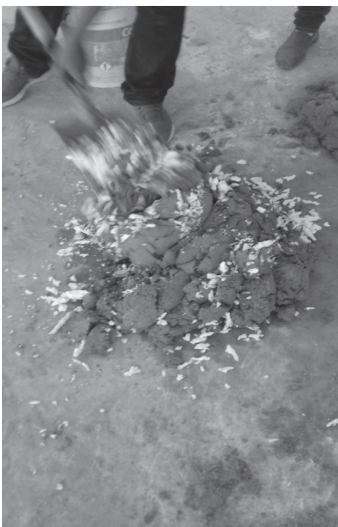
FIGURA 5, 6 Y 7. PROCESO DE RELLENO CON LA MEZCLA DE SUELO Y DIFERENTES AGREGADOS. FUENTE: FOTOGRAFÍAS DEL AUTOR.
