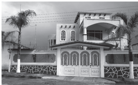
FIGURA 6. VIVIENDA NUEVA CONSTRUIDA CON PLANOS.
