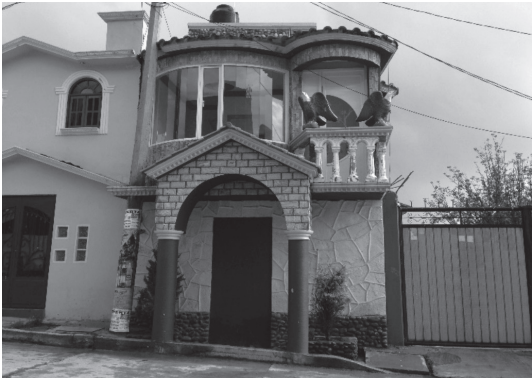
FIGURA 2. VIVIENDA CONSTRUIDA Y EN DESUSO EN SAN SIMEÓN XIPETZINCO. FUENTE: GALERÍA PROPIA RESULTADO DE LA VISITA A LA LOCALIDAD DE ESTUDIO, 2017.
