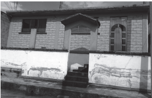
FIGURA 5. USO DE ALUMINIO DORADO PARA MARCOS DE PUERTAS Y VENTANAS. FUENTE: GALERÍA PROPIA RESULTADO DE LA VISITA A LA LOCALIDAD DE ESTUDIO, 2017.
