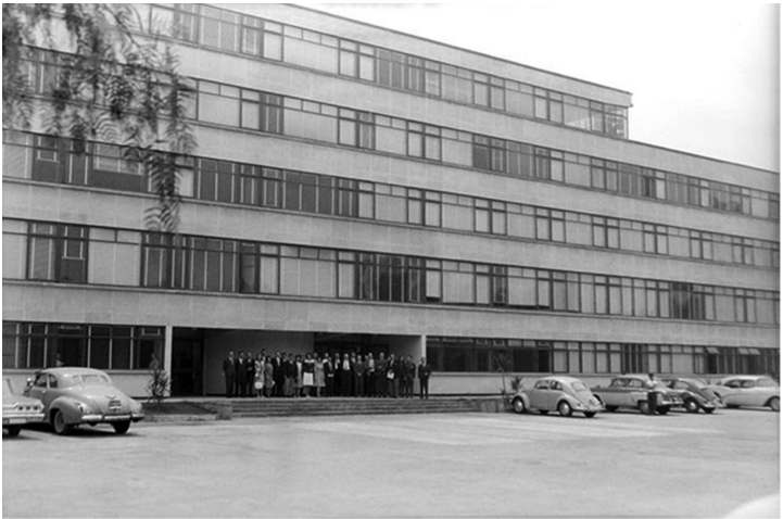
FIGURA 9. FOTOGRAFÍA DE LA UNIDAD DE HABITACIONES PARA ESTUDIANTES TRANSFORMADA EN OFICINAS ADMINISTRATIVAS, CA. 1965. SE ACUSA LA MODIFICACIÓN DE LA PLANTA BAJA Y LA ELIMINACIÓN DE LA IDEA DE PLANTA LIBRE Y PILOTIS.
