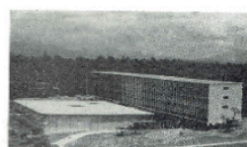
FIGURA 5. ARTÍCULO "HABITACIONES TIPO PARA ESTUDIANTES" PUBLICADO EN ARQUITECTURA MÉXICO 39. SE OBSERVA QUE LA UNIDAD TIPO SE COMPONE DE DOS ELEMENTOS PRINCIPALES, EL CUERPO DE VIVIENDA DE CINCO NIVELES Y EL APÉNDICE DE SERVICIOS DE UN NIVEL CON MEZZANINE.
