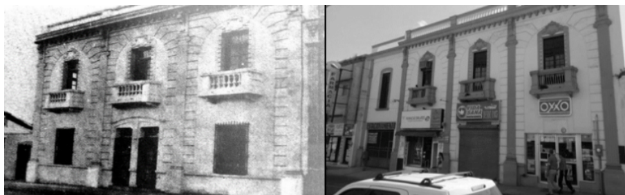
IMAGEN 2. Comparativo de los edificios, el original de 1923 y el actual. (Gobierno del estado de Tamaulipas, 1999).
