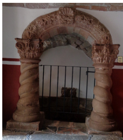
FIGURA 4. DETALLE DEL ACCESO AL BAÑO DE LA CELDA DE LA MONJA PIMENTEL.
